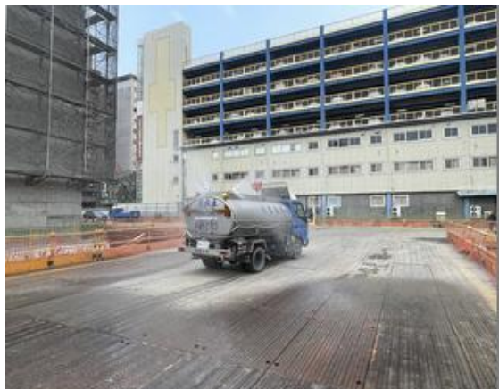
土方作業構台灑水降低揚塵
