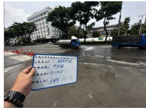
出口路面灑水
