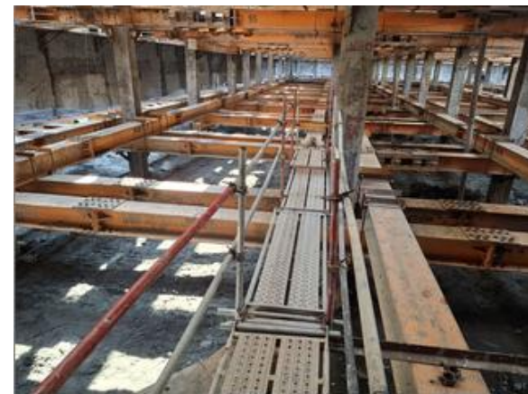
監測安全步道架設
