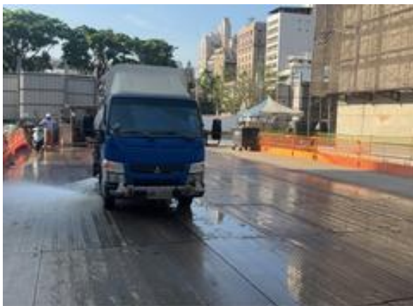
土方作業構台灑水降低揚塵
