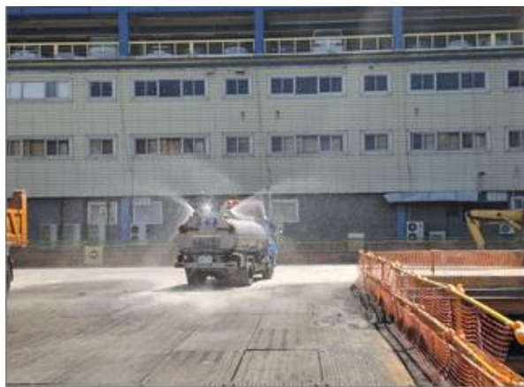
土方作業構台灑水降低揚塵
