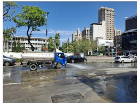
出口路面灑水
