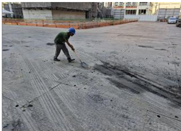
土方作業後構台版面清餘土
