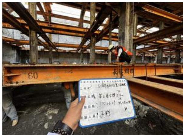
配合支撐架設-支撐應力計安裝
