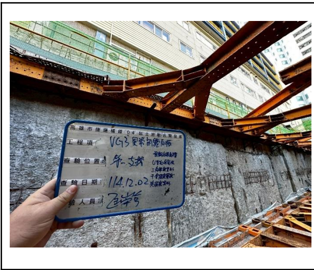
型鋼與水平斜撐對接處-無變形
