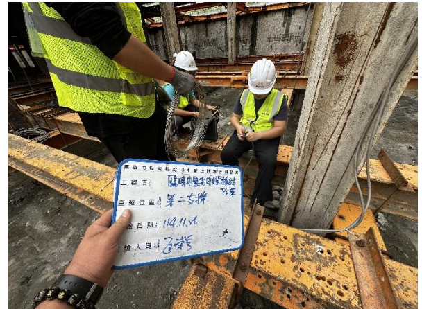
臨時電盤與照明佈線作業
