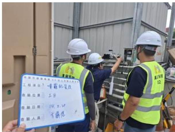
熱危害預防作業-噴霧系統配管安裝
