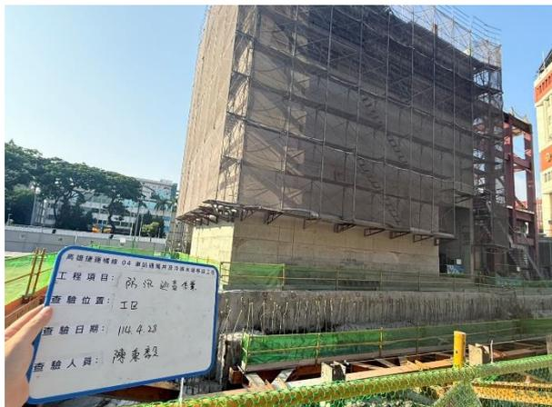
一.通風井築牆作業達防汛高度
