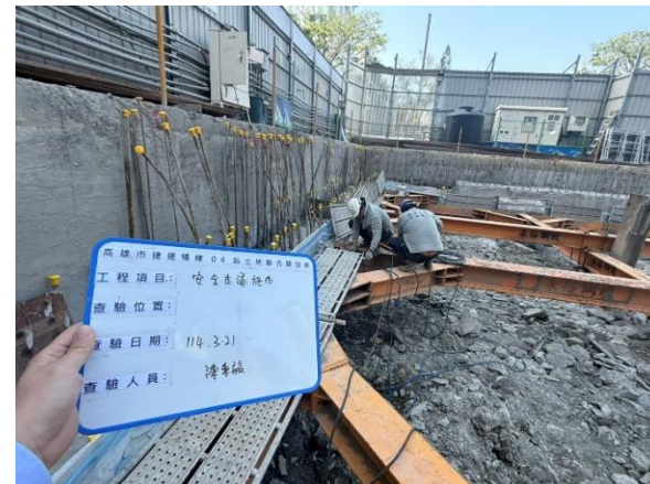
工地四周安全走道架設防護欄
