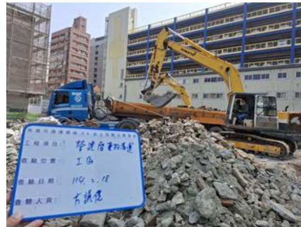
原203巷巷道路基挖掘出 廢棄物紅磚
