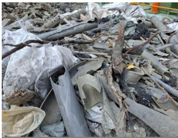
原中正四路203巷巷道路基挖掘出廢棄物紅磚/枯木/舊有自來水幹管等,依法進行篩檢分類、棄運
