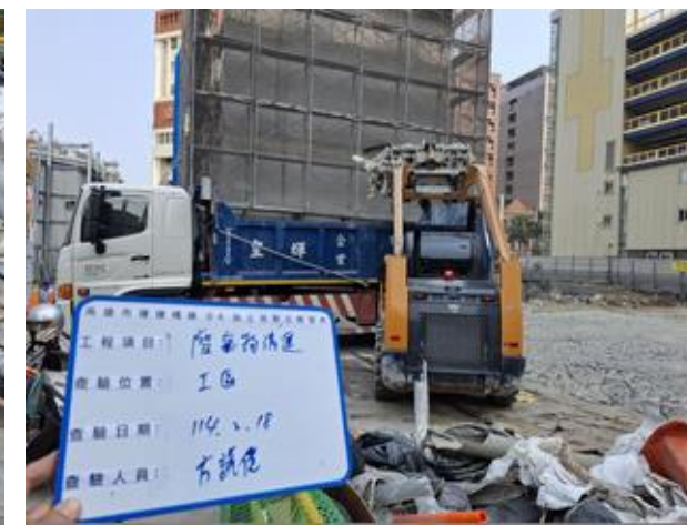
原中正四路203巷巷道路基挖掘出廢棄物紅磚/枯木/舊有自來水幹管等,依法進行篩檢分類、棄運
