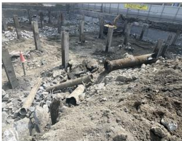
原中正四路203巷巷道路基挖掘出廢棄物紅磚/枯木/舊有自來水幹管等,依法進行篩檢分類、棄運
