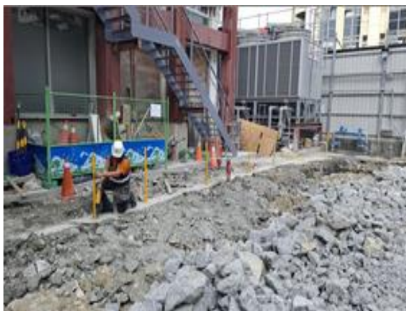
搭配開挖作業架設四周護欄
