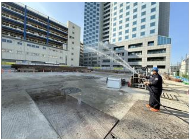
工區灑水抑制揚塵
