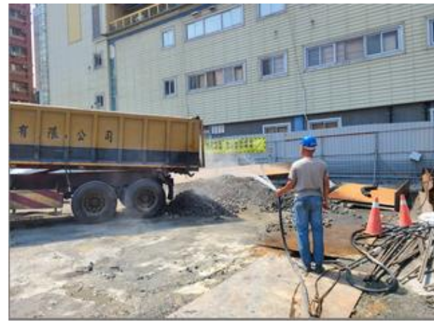
工區內灑水防塵並降溫
