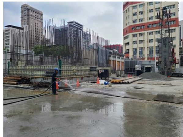
工區灑水防制揚塵
