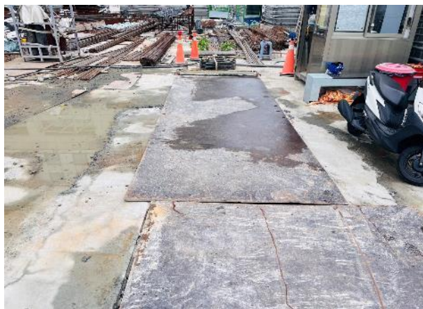
導溝鐵板滿鋪防墜
