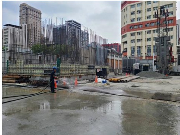
工區灑水防制揚塵
