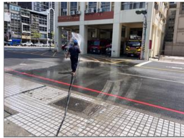
工區車輛進出清洗路面
