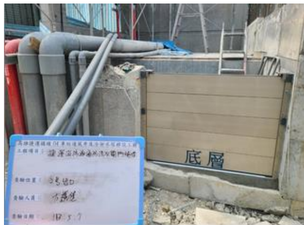
防汛作業-防水閘門施作完成
