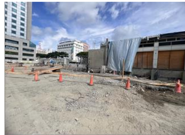
作業半徑區隔防護作業
