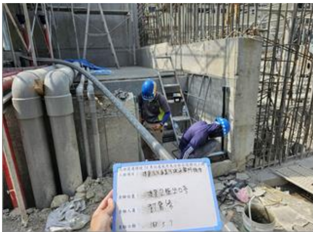
防汛作業-防水閘門安裝
