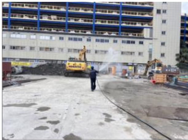
工區內灑水防塵
