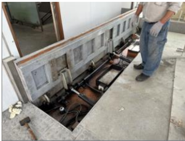
配合捷運公司防洪閘門測試
