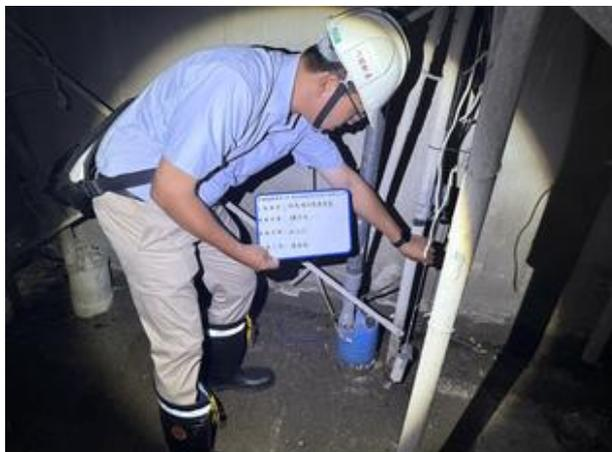
通風井防汛作業-抽水馬達運轉檢測 正常
