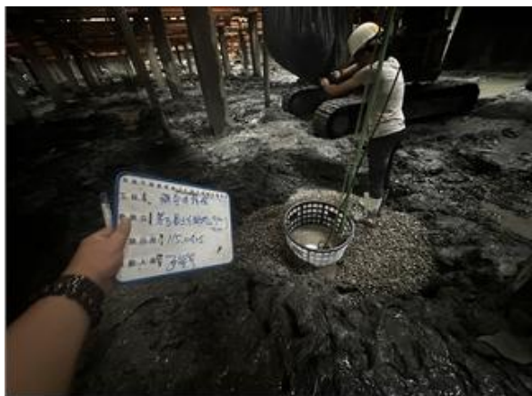
開挖面佈設馬達抽水作業
