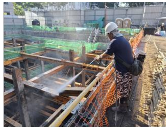
水平支撐面餘土沖洗作業
