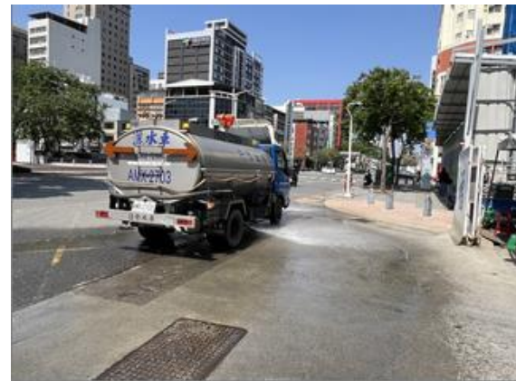
出口路面灑水
